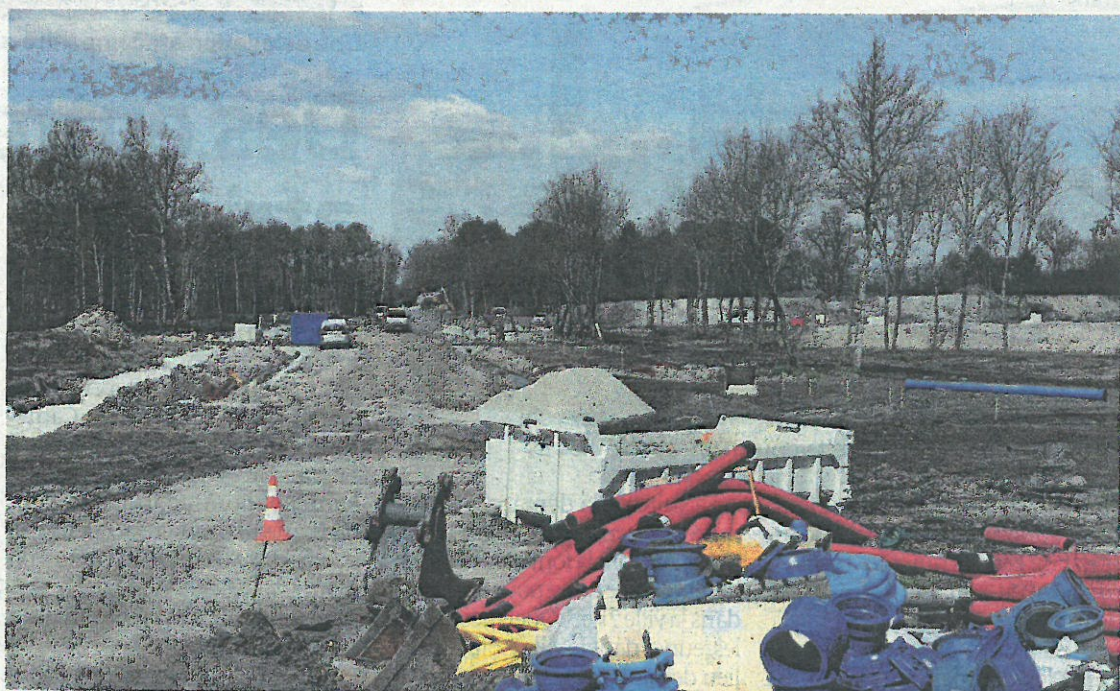
20 hectares sont en cours de transformation actuellement dans le quartier de Beaudésert, pas loin de l'aéroport. 80 entreprises pourraient s'y implanter. PHOTO FABIEN COTTREAU
